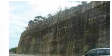
Склоновете са направени гладки независимо от тяхната височина. Така те имат трайност и добър естетичен външен вид
