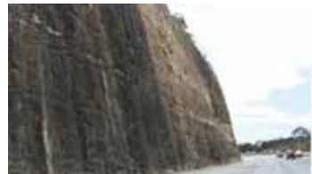
Склоновете са направени гладки независимо от тяхната височина. Така те имат трайност и добър естетичен външен вид
