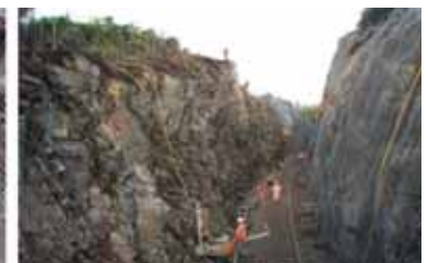
Грапабата повърхност се компенсира от защитна метална мрежа. По този начин обаче не се постига трайност и в бъдеще са необходими средства за поддръжка и ремонт на откосите и мрежите
