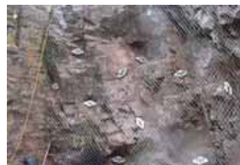
Грапабата повърхност се компенсира от защитна метална мрежа. По този начин обаче не се постига трайност и в бъдеще са необходими средства за поддръжка и ремонт на откосите и мрежите
